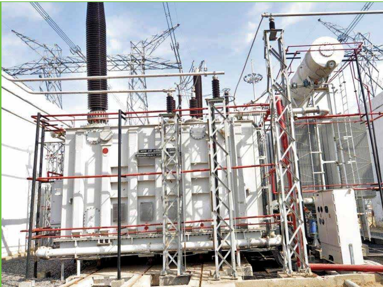
पीएफसी द्वारा वित्तपोषित डब्ल्यूपीपीटीसीएल का ग्रेटर नोएडा सब-स्टेशन 765वी-500एमवीए सिंगल फेज ट्रांसफॉर्मर
