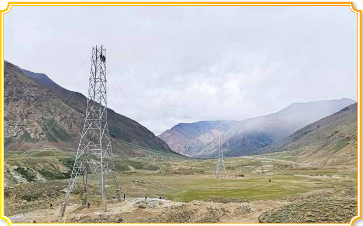
कारगिल, लद्दाख में डबल सर्किट टावर पर ट्रांस से पदुम तक 220 केवी सिंगल सर्किट ट्रांसमिशन लाइन का कार्यान्वयन आरईसीपीडीसीएल द्वारा किया जा रहा है
